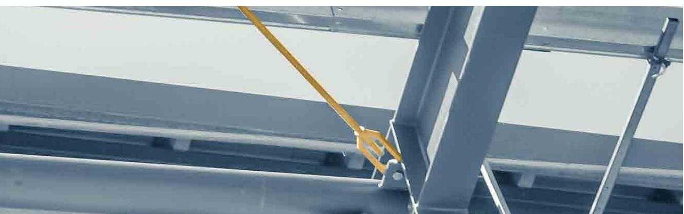
El sistema de tirantes SAS LokTie con barras rosca-das de alta resistencia para el refuerzo de arriostramientos en la construcción industrial y de naves es la alternativa moderna a tirantes embulonados, cintas soldadas y barras sometidas a tracción con rosca fina. El sistema SAS LokTie cumple de manera óptima las exigencias que se dan en las construcciones con tirantes.
